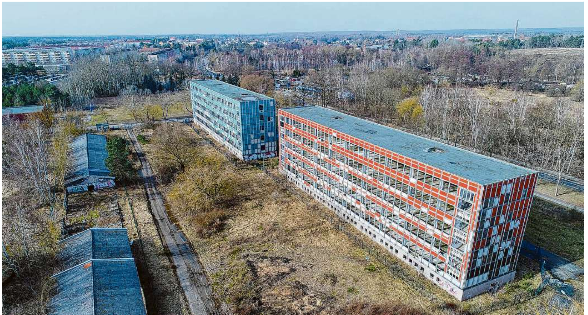
Block der Schande abgerissen: Auf dem Areal des alten Finanz- und Arbeitsamtes in Finow wird eine neue Schule gebaut.
